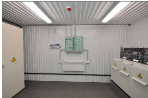
Совмещенный отсек РУВН и РУНН
